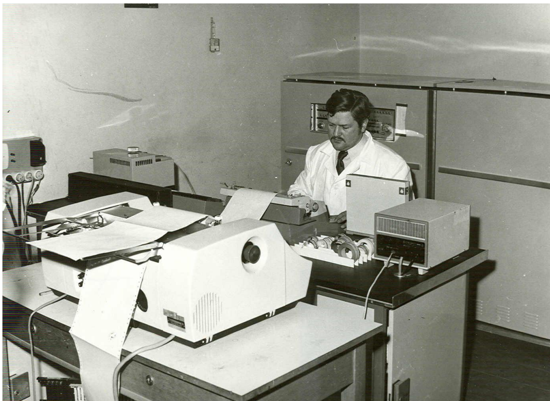
Malodosková verzia počítača RPP-16S na Ústave technickej kybernetiky v roku 1971, pri písacom stroji Štefan Beleš, technik-špecialista RPP-16 (Zdroj: Stála výstava dejín VT)
