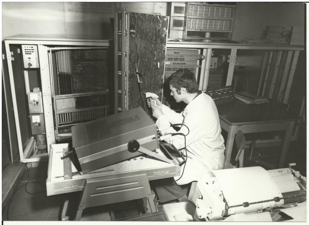
Montáž malodoskovej verzie počítača RPP-16S vo Výskumno-vývojovom stredisku Tesly Orava v Žiline (neskôr VVL Žilina), 1970/1971. (Zdroj: Ing. Podracký, VVL Žilina)
